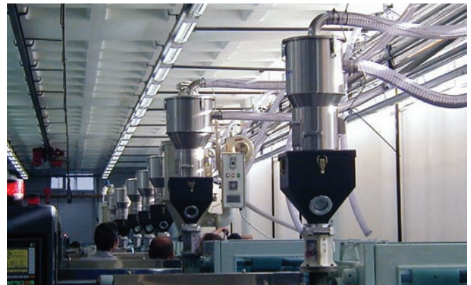
Vakuumabscheider Typ SVR und isolierte Materialbehälter
